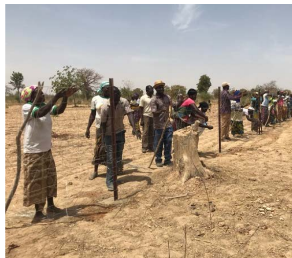
Gute Zusammenarbeit bei der Herstellung der Schutzzäune
