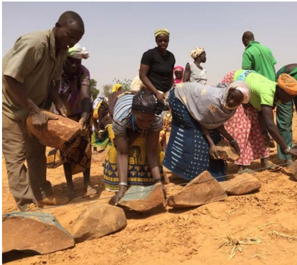
Errichten einer Steinmauer zur Wasserretention
